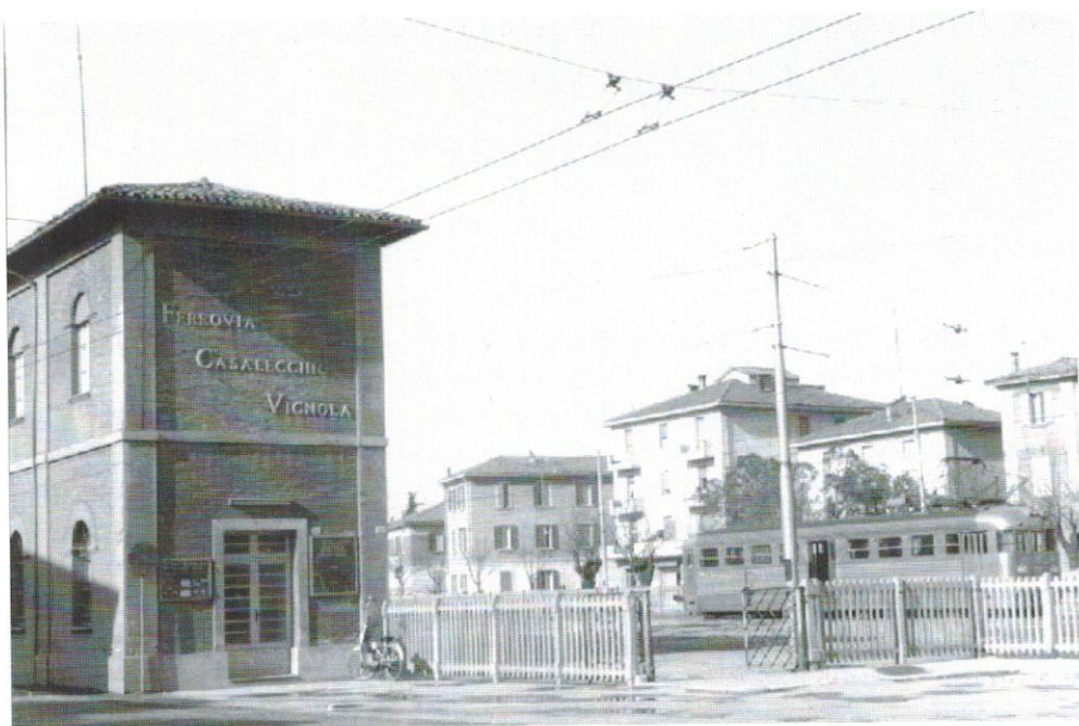
La stazione di Casalecchio fotografata nel 1965. È visibile in sosta una elettromotrice Piaggio, la cui cassa era interamente in acciaio inossidabile (foto R. Cesa de Marchi)
