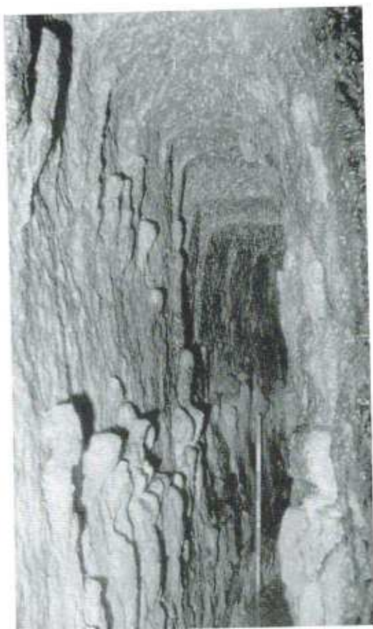
Fotografia del cunicolo con incrostazioni calcaree
