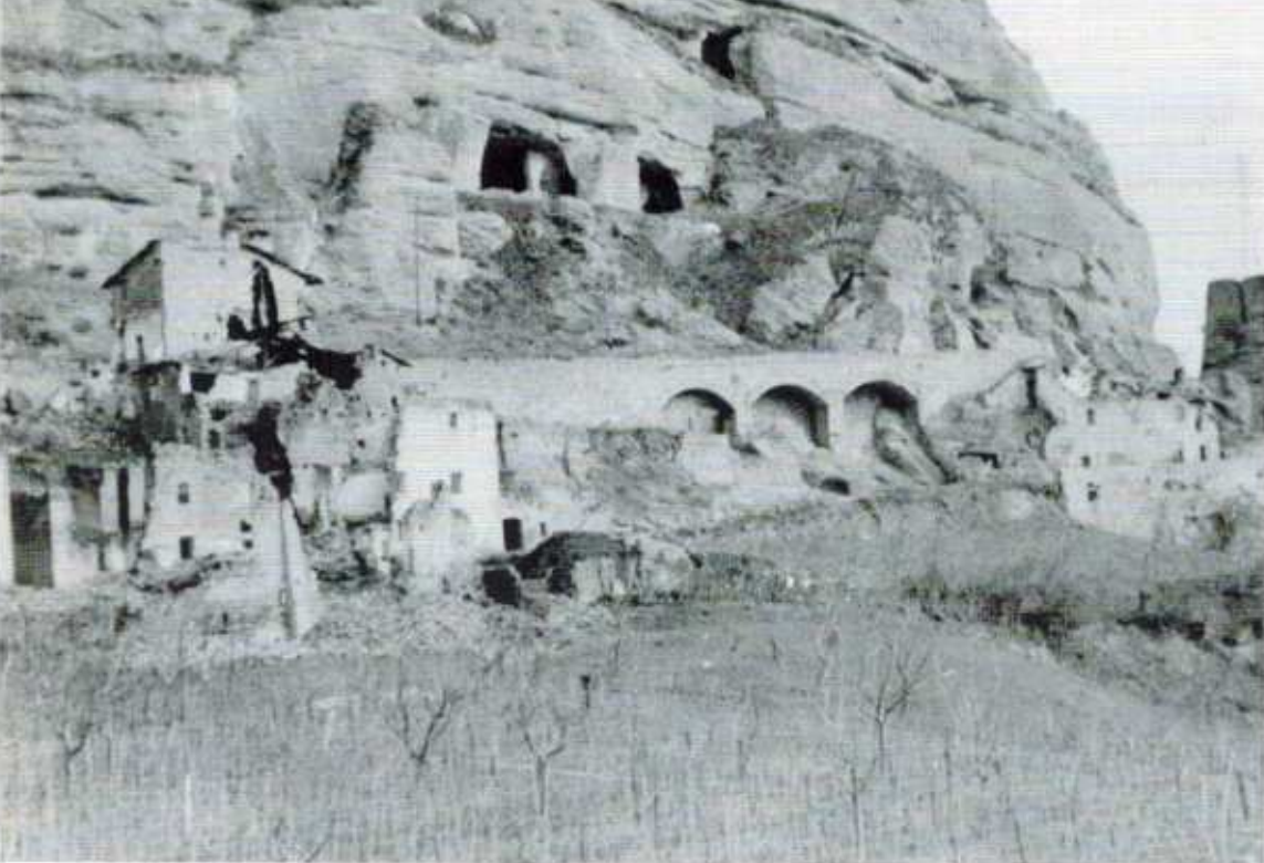
Le vecchie cave di arenaria della Rupe ed i resti delle abitazioni di Case Gasparri alla Fontana nell'immediato dopoguerra, fine 1945 (Archivio Storico Comunale Sasso Marconi)
