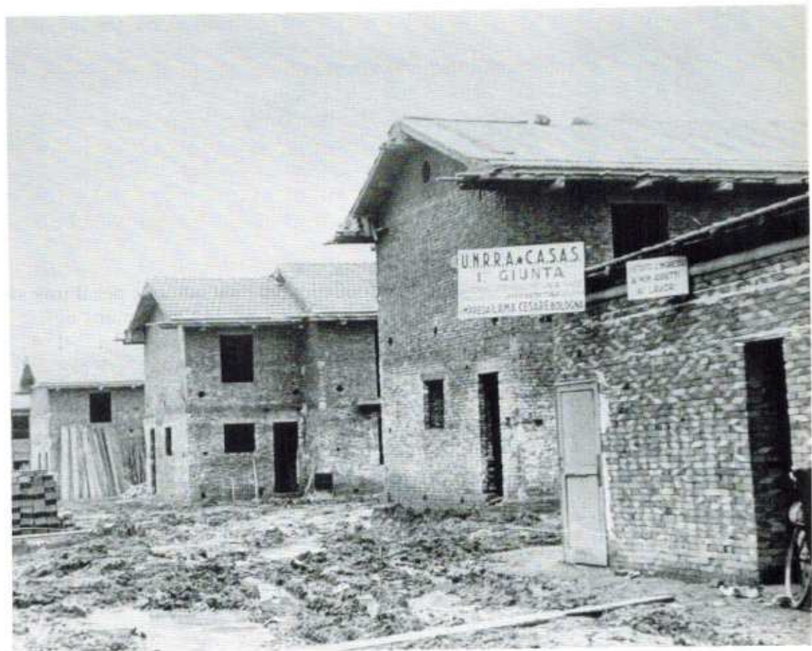
Nella pagina accanto: la ricostruzione nel dopoguerra; cantiere UNRRA-CASAS a Pontecchio nel 1949-1950 (Archivio Storico Comunale Sasso Marconi).
