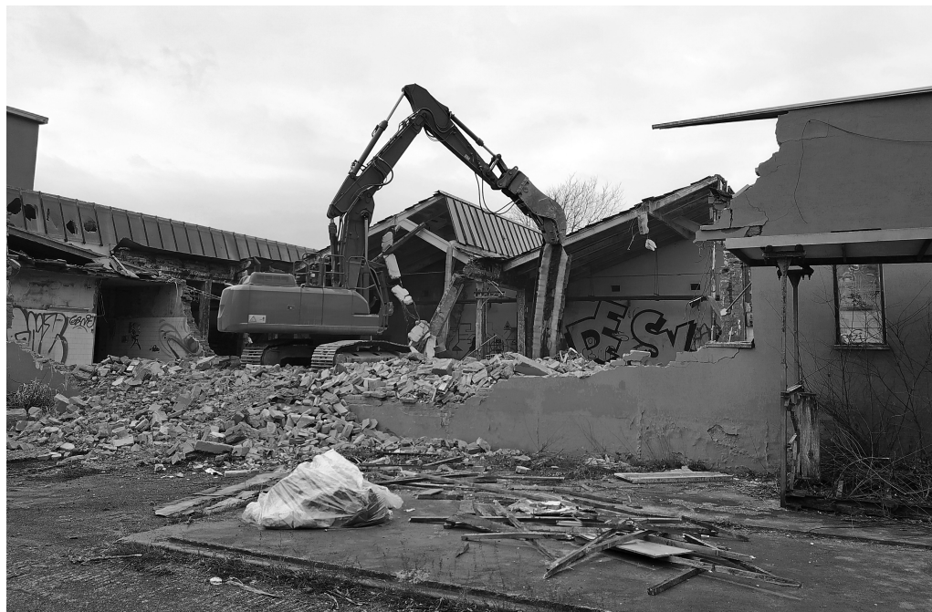
Fig. 1. Gennaio-febbraio 2025: demolizione del complesso industriale ex-Metalplast: ruspe al lavoro nell'area occupata dai capannoni della ditta attiva a Sasso Marconi dal 1958 ai primi anni 2000 (foto Glauco Guidastrì).
