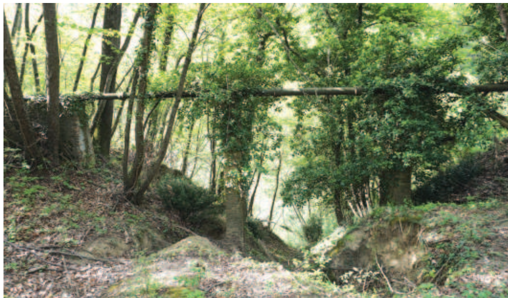
Fig.13. Tubazione su pilastri del tratto più a valle, 2024 (foto Mauro Filippini).
