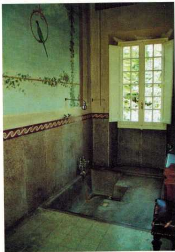
Particolare della sala da bagno con la bella vasca incassata in graniglia e la rubinetteria inglese: si notino le pareti dipinte a pergolato con uccelli.
