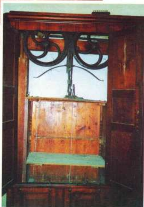
Il mobile con il saliscendi a mano che connette i diversi piani della villa per trasportare gli alimenti.
