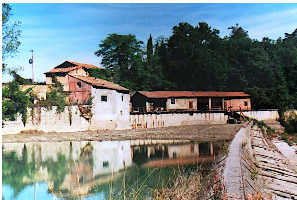
Fig. 11. La traversa sul Reno e sullo sfondo l'edificio della Barca che un tempo era il luogo di attracco del traghetto e abitazione del barcaiolo, e la casa di guardia per il controllo e la regolazione delle paratoie di afflusso dell'acqua nel canale. Sulla destra la segheria (foto Luigi Ropa Esposti).
