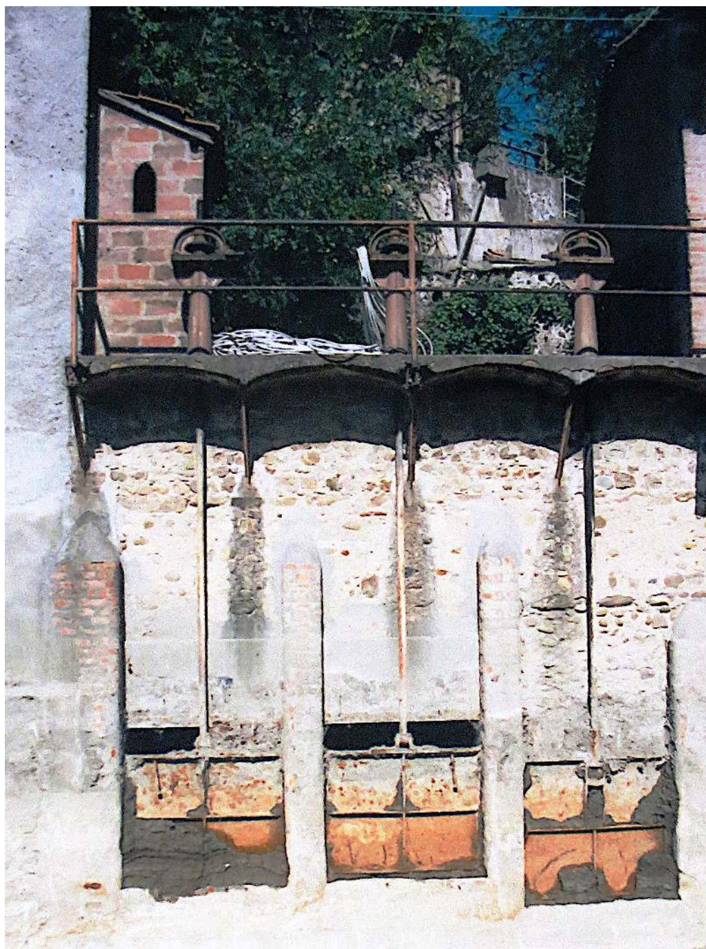
Fig. 12. Le paratoie per la regolazione del deflusso dell'acqua in eccesso nel Reno dell'acqua nel canale (foto Luigi Ropa Esposti).
