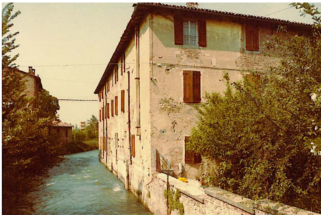
Fig. 14. Uno dei fabbricati della Pila, posto a margine del canale del Maglio, in una foto degli anni '70, prima della ristrutturazione (Archivio Ufficio Tecnico Comune di Sasso Marconi).
