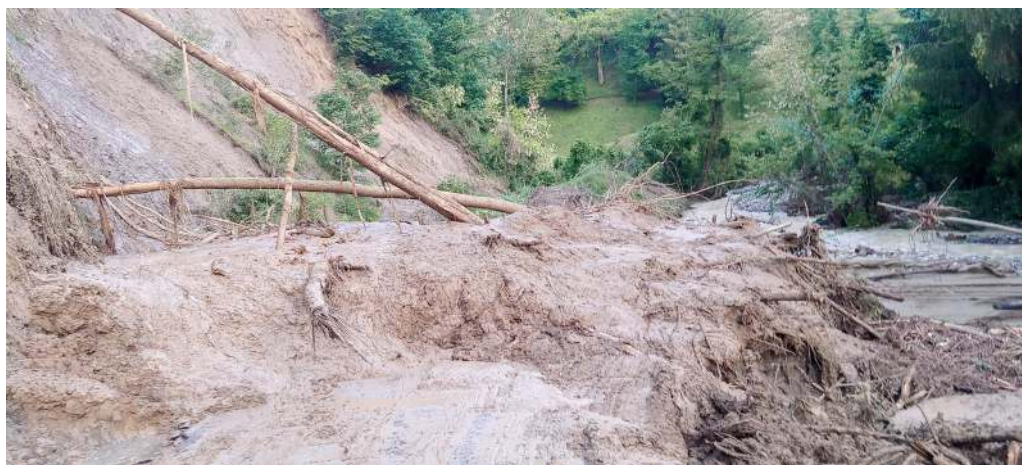
Fig. 2. Una delle frane che il 17 maggio hanno investito la strada di via Sant'Anna, costringendo all'evacuazione di tutti i residenti, alcuni dei quali in elicottero (foto Luigi Ropa Esposti).
