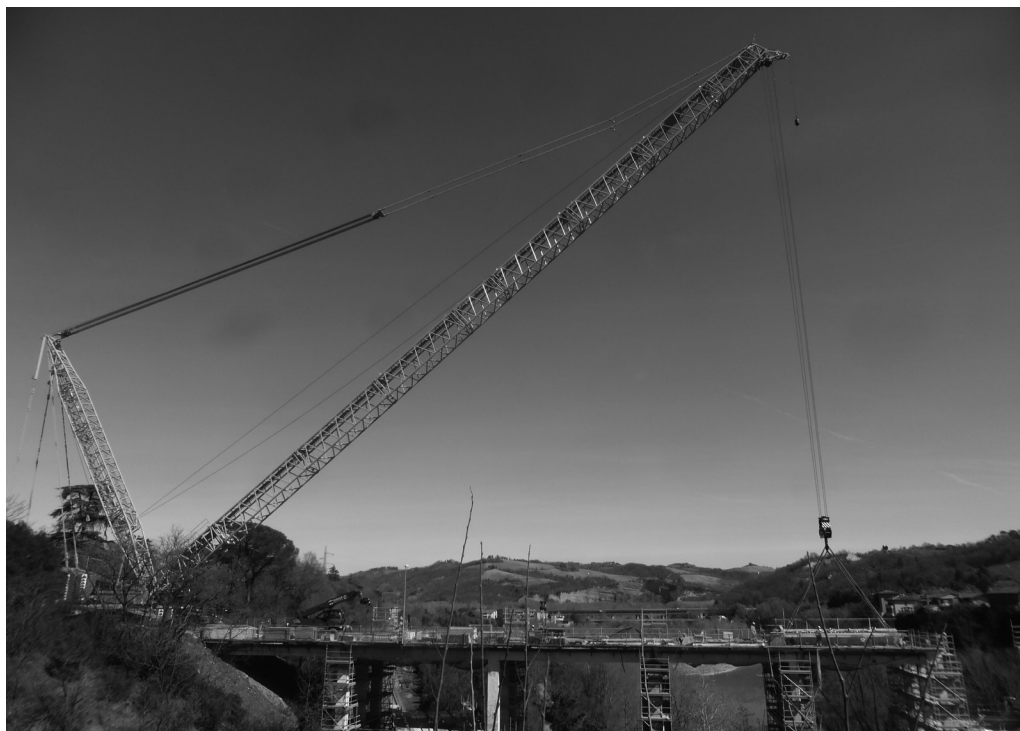
Fig. 4. Marzo 2023: una delle imponenti gru durante i lavori di smontaggio dell'impalcato del ponte Da Vinci (foto Luigi Ropa Esposti).
