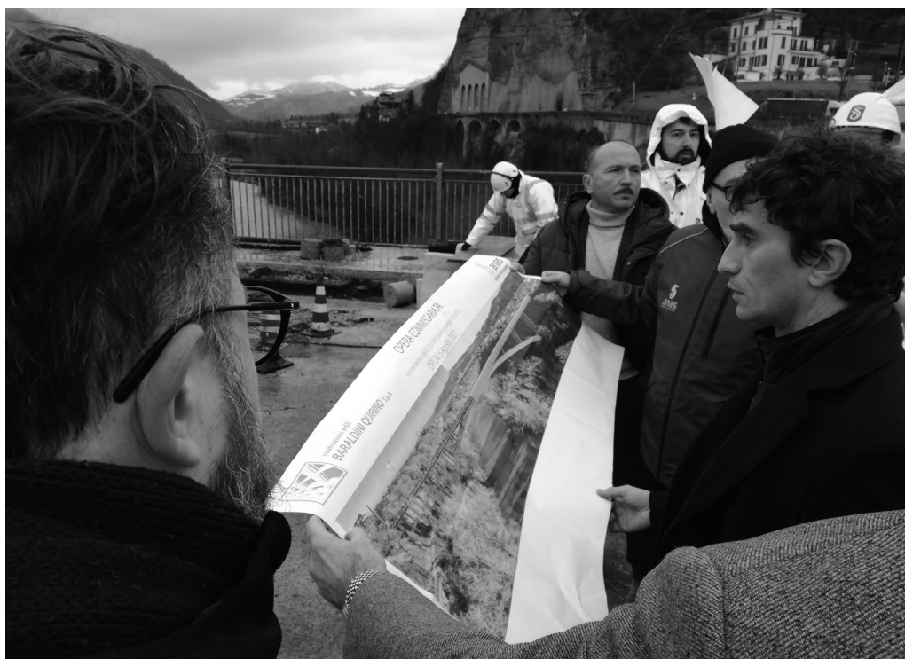
Fig. 3. Febbraio 2023, avviati i lavori di “decostruzione” del ponte Da Vinci. Il Vice Ministro delle Infrastrutture e dei Trasporti, Galeazzo Bignami, durante il sopralluogo sul ponte Da Vinci del 27 febbraio 2023 (foto Glauco Guidastrì).
