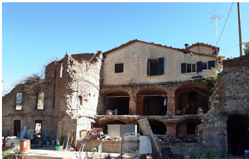
Fig. 11. La struttura del vecchio mulino ripresa durante l'inizio dei lavori di ristrutturazione nell'estate del 2021 (foto di B. Sidoli, F. Venturini).
