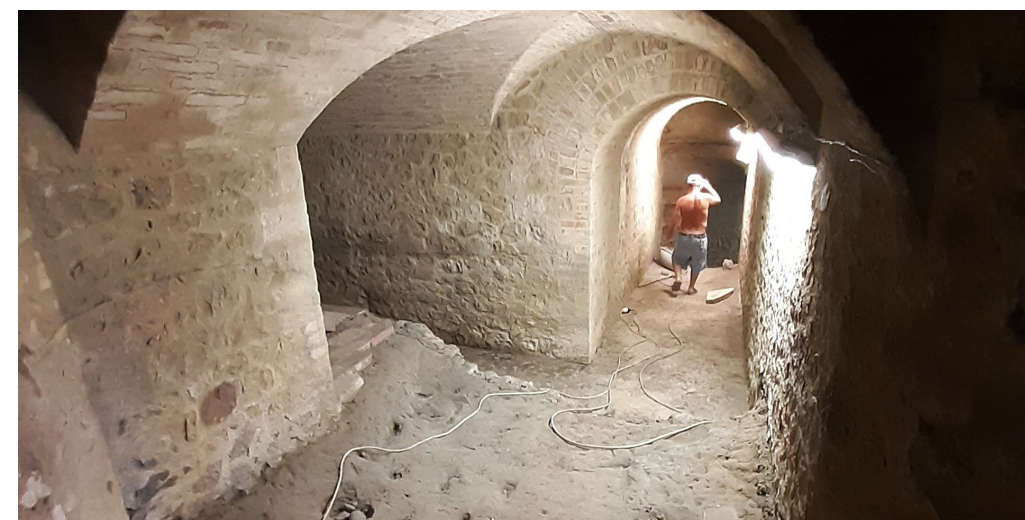
Fig. 10. Passeggiata lungo i condotti di alimentazione e scarico delle acque. Da notare la notevole ampiezza delle gallerie (foto di B. Sidoli, F. Venturini).
