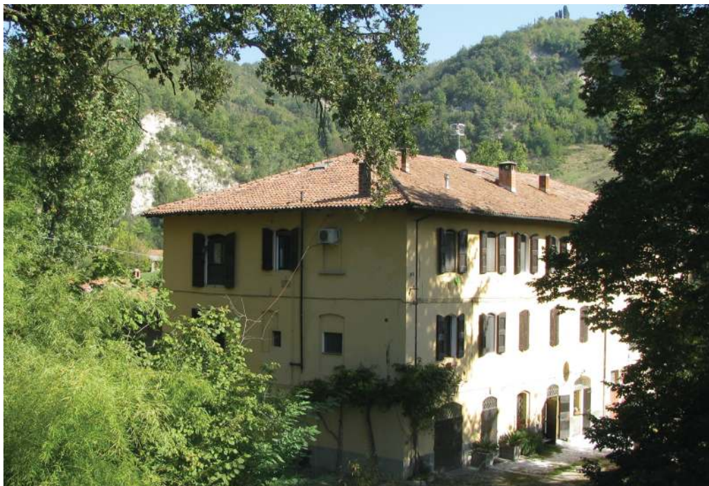
Fig.9. Parte posteriore della struttura a tre piani del Mulino dei Frati come si presenta oggi, all'ombra delle querce secolari che coronano la parte alta della proprietà (foto B. Sidoli, F. Venturini).
