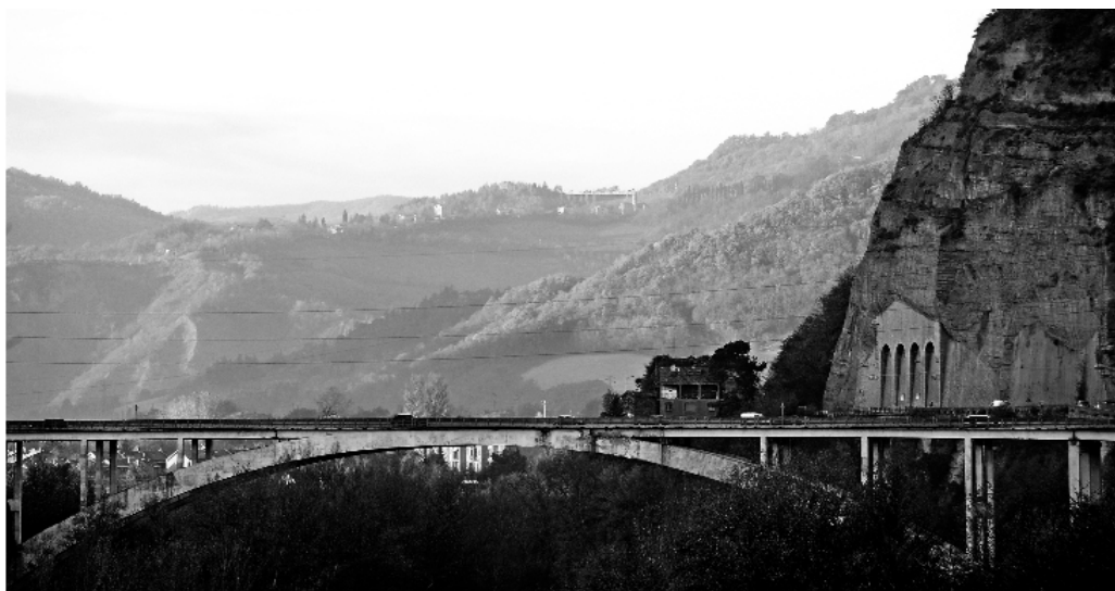
Figg. 2 e 3. Dicembre 2020 la chiusura del ponte Leonardo da Vinci. Il ponte "da Vinci" ancora in attività in una suggestiva immagine (foto Sergio Marchioni). Nella foto in basso: il ponte come si presenta oggi, completamente chiuso al traffico (foto Uff. Stampa Comune di Sasso Marconi).
