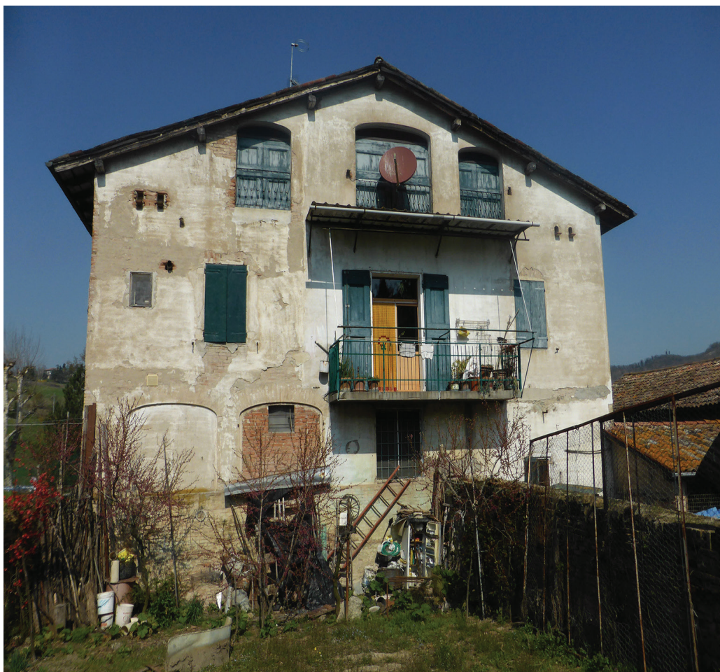
Fig. 8. La facciata dell'ex Molino Baiocca dove vi erano la botte e l'ingresso delle acque provenienti dal canale di derivazione dal torrente Olivetta; sulla destra è ancora visibile uno dei muri in sasso che contenevano la botte delle acque (foto Luigi Ropa Esposti).
