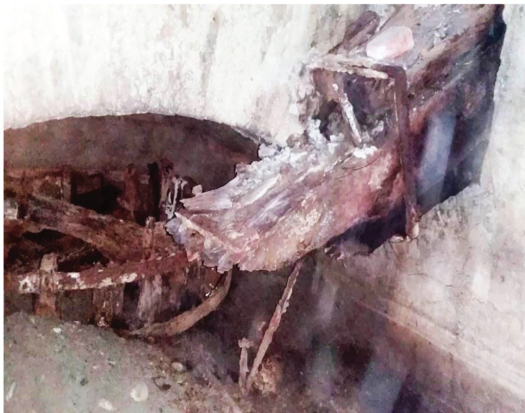
Fig. 9. Ciò che rimane oggi dei locali nell'interrato in cui vi erano le pale mosse dall'acqua (foto B. Sidoli, F. Venturini).
