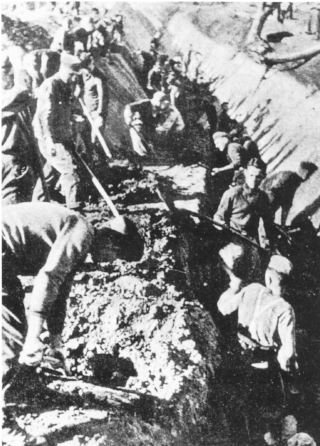
Fig. 10. Prigionieri che scavano per la realizzazione di un fossato anticarro (da Feldbefestigungen des deutschen heeres 1939 1945).
