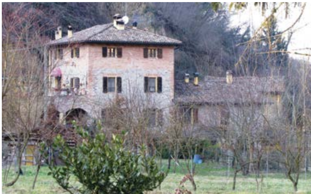
Fig. 31 Il complesso abitativo dell'ex Mulino Ventura-Gardellino come si presenta oggi (foto B. Sidoli, F. Venturini).
