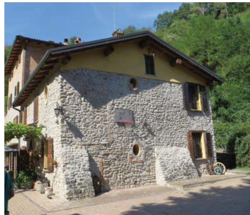
Fig. 25 Il complesso del Mulino Ventura come si presenta oggi ristrutturato ad uso abitativo. Da notare la facciata di quello che un tempo era il locale delle macine (foto B. Sidoli, F. Venturini).
