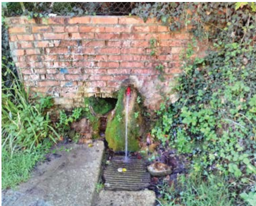
Fig. 12. La sorgente di Sant'Anna, posta in prossimità del Mulino di Sopra (foto B. Sidoli, F. Venturini).
