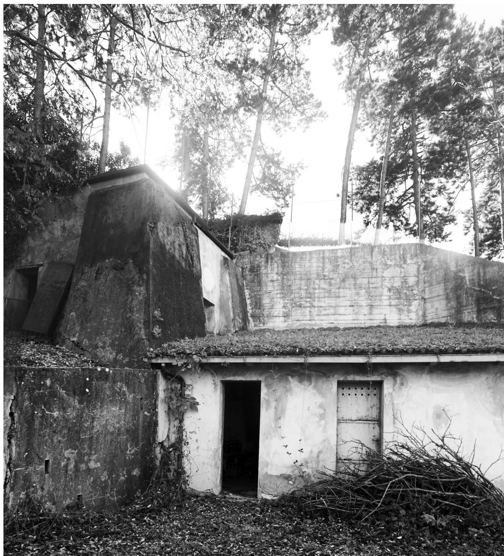
Fig.17. Esterno dell'edificio in cui si trova la fonte Marcella. Sulla parte sovrastante sorgeva la villa distrutta dai bombardamenti dell'ultima guerra (foto Mauro Filippini).
