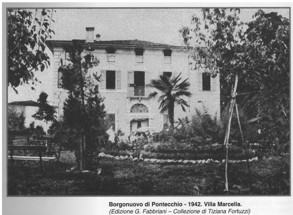
Fig. 4. La villa con il grande parco prima della distruzione per eventi bellici (da "Sasso&Dintorni", 13.ma edizione).
