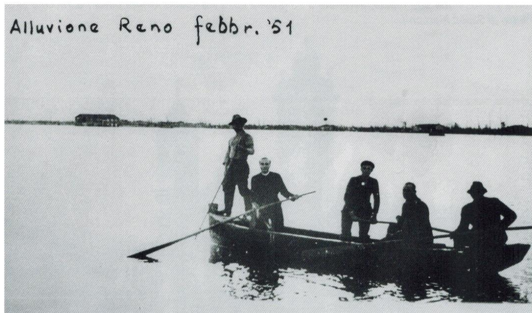
Fig.6. Don Dario impegnato nel prestare soccorso alla popolazione colpita dalla disastrosa alluvione del fiume Reno nel febbraio 1951 (foto fornita dalla Parrocchia di S. Pietro di Sasso Marconi).
