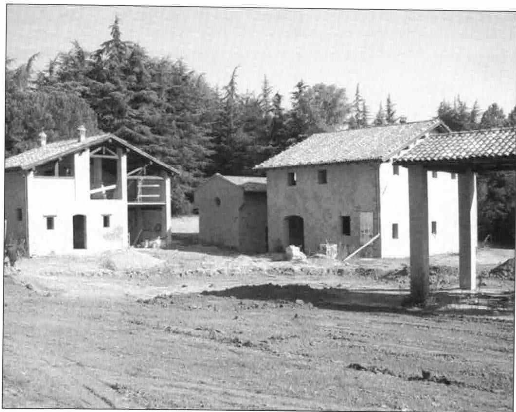
Veduta d'insieme dei Fabbricati del Podere "Casetto" durante i recenti lavori di ristrutturazione.
