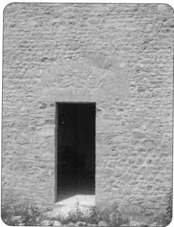
La vecchia facciata in sasso in cui sono rintracciabili gli interventi di modifica dell'apertura (notare la precedente volta ad arco in muratura).
