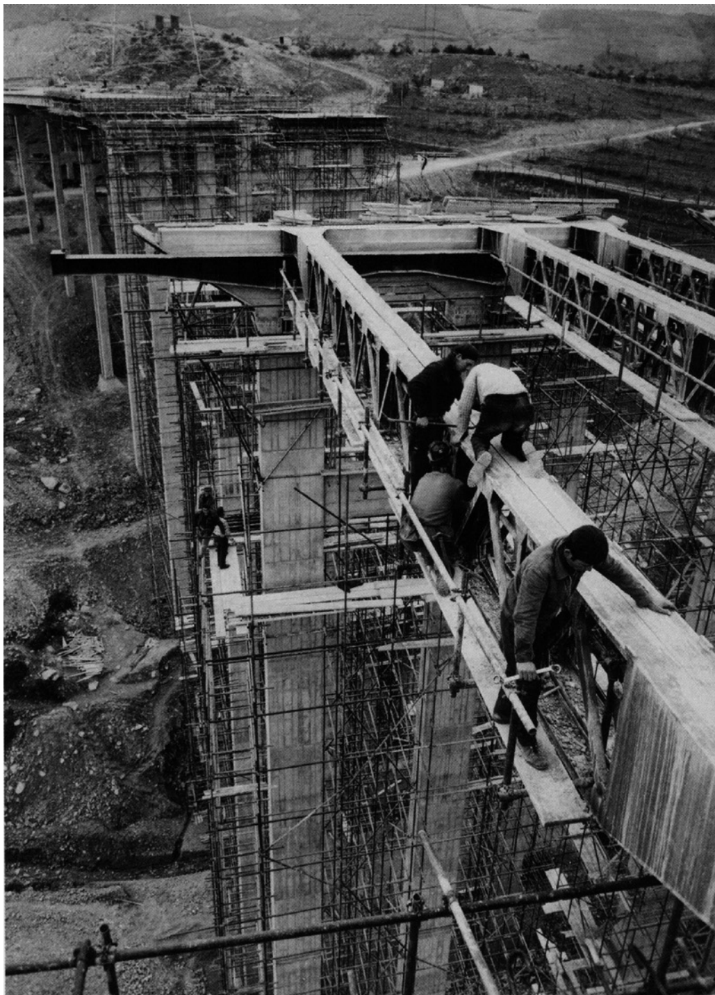
Fig.2 Operai al lavoro per la costruzione del viadotto sul torrente Aglio. Da notare l'assenza di misure di sicurezza per gli operai (dalla rivista "Autostrade").
