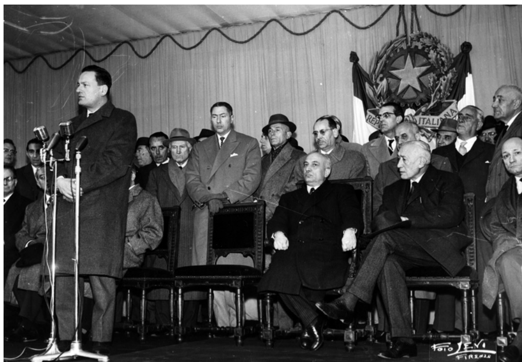
Fig.7 Casalecchio di Reno, 3 dicembre 1960: dopo il taglio del nastro sul versante toscano il Ministro dei Lavori Pubblici Benigno Zaccagnini pronuncia il discorso ufficiale presso il casello di Bologna sud (Casalecchio di Reno). Alle sue spalle il Presidente del Consiglio Amintore Fanfani (foto Levi, Firenze).
