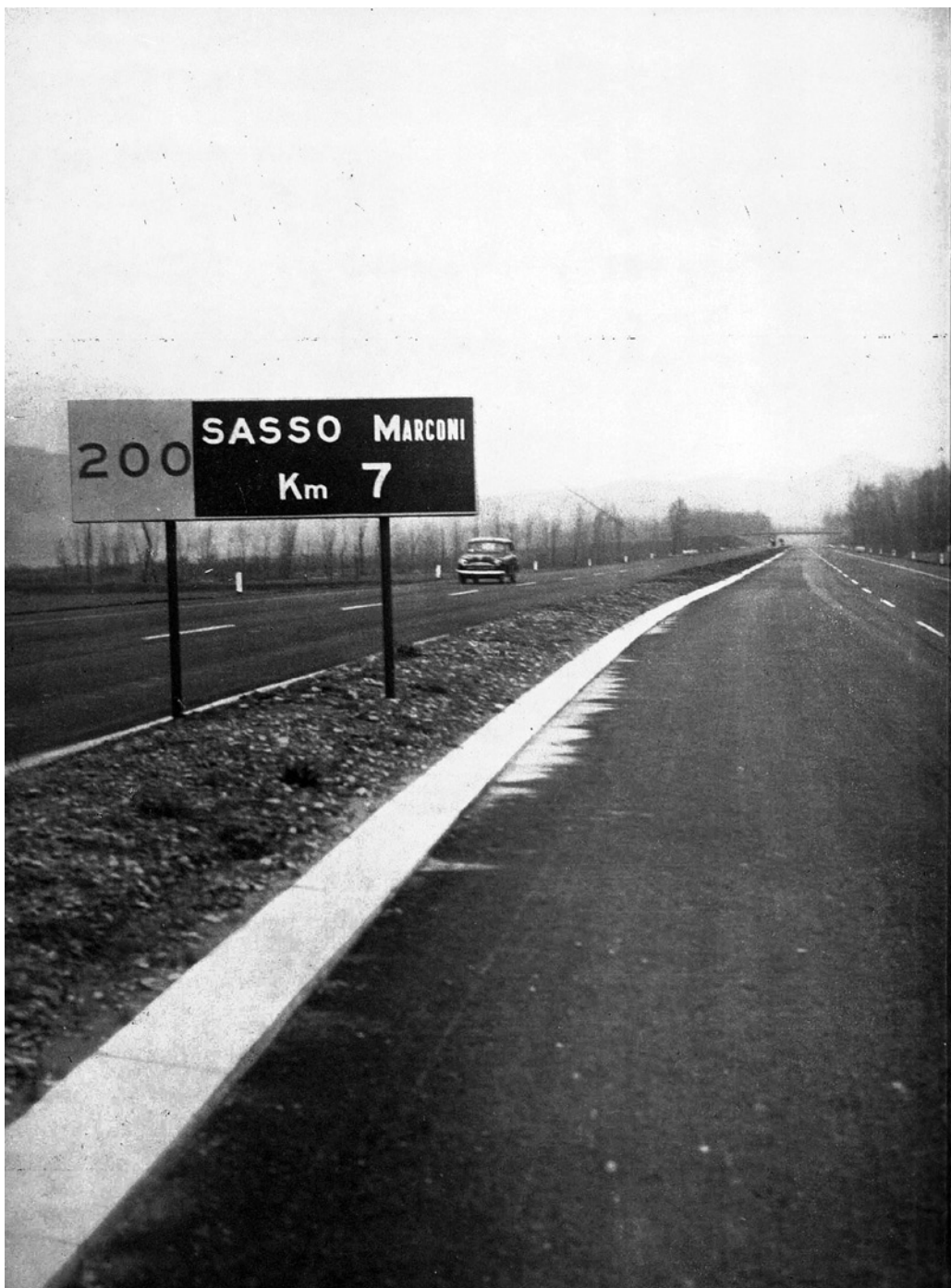
Fig.4 Il tratto tra Bologna sud e Sasso Marconi. Foto scattata nel 1959, quando ancora per andare a Firenze occorreva uscire a Sasso e fare la Porrettana o la Val di Setta. Da notare la scarsità del traffico e l'assenza di barriere di sicurezza tra le due carreggiate (dalla rivista "Autostrade").
