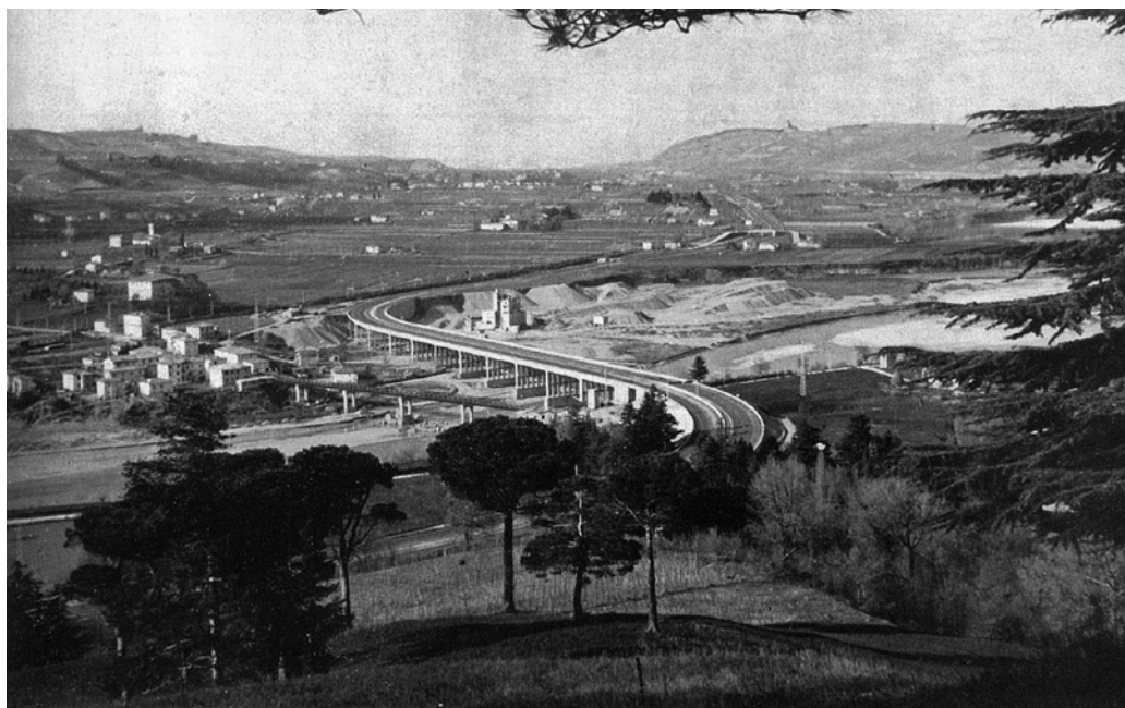
Fig.10 Foto del 1959 del viadotto sul Reno poco prima dell'apertura del tratto fino a Sasso Marconi. Da notare la curva del Km 206, in corrispondenza del ponte, che tante fuoriuscite ha causato prima di essere abbandonata e sostituita nel 2006 dal nuovo tracciato. Per chi proveniva da Milano era la prima vera curva che si affrontava dopo 200 km (dalla rivista "Autostrade").
