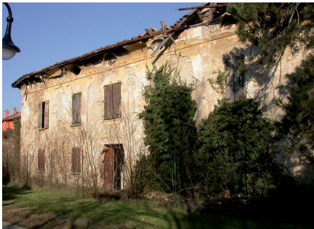
Fig.9. Palazzina Davia, fronte sud. Sono riconoscibili gli elementi propri della tipologia della palazzina di campagna cinque-seicentesca, caratterizzata da una volumetria compatta e una composizione rigorosamente simmetrica del fronte; la porzione di facciata su cui si aprono le tre finestre centrali è riconducibile al nucleo "originario" dell'edificio, mentre le due finestre laterali si aprono sulle due ali aggiunte in un secondo momento (foto E. Gentilini, 2006).
