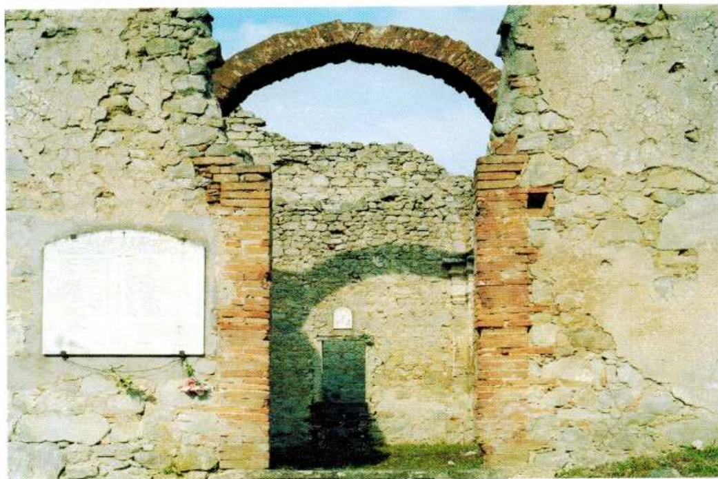
Fig.1. Marzabotto, Parco Storico di Monte Sole. I ruderi dell'oratorio di Cerpiano, dove ebbe luogo un eccidio di abitanti nel settembre del 1944.
