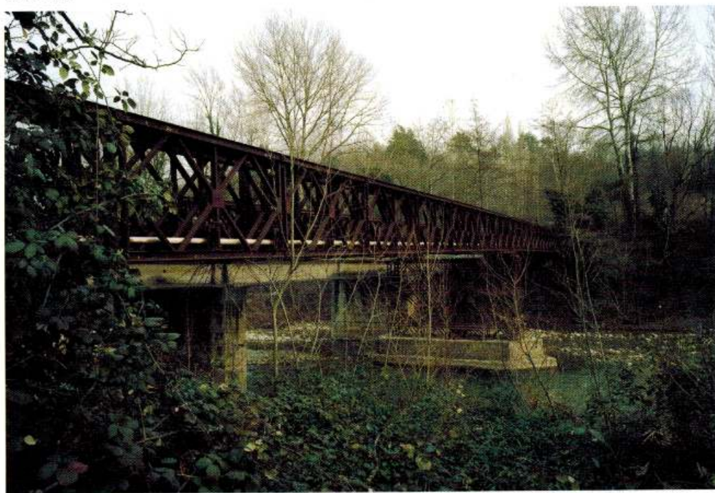
Fig.9. Castel del Rio (Bologna). Località Carseggio. Ponte militare alleato "Bailey" sul fiume Santerno.
