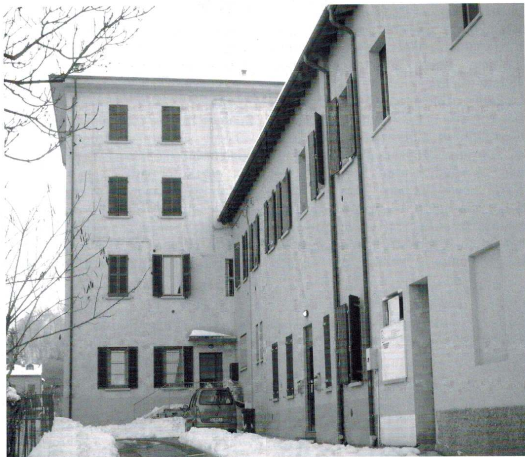
Fig.5. Una foto recente dell'edificio in Via della Stazione di due piani (sulla destra) dove negli anni '60 ebbe sede, al secondo piano, il club "il Trastullo" (foto Paolo Michelini).
