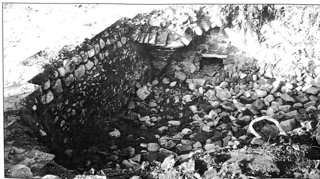
Particolare dei resti della cripta (la Chiesa fu fatta saltare dai nazisti durante la ritirata) – (Foto I. Fini).
