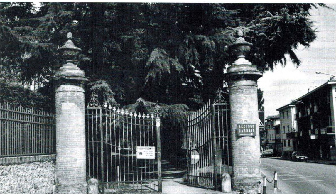
Il cancello di ingresso a villa Marini provenendo dalla piazza, con le classiche "zuccheriere" sulle colonne
