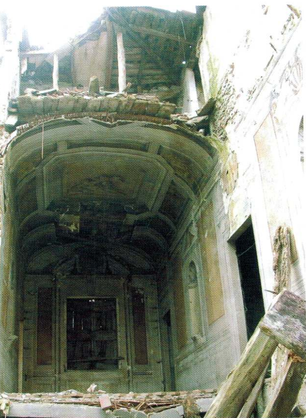
Immagine 2. (gennaio 2006). Loggia della palazzina già di proprietà della famiglia Davia nel XVII secolo, poi diventata il fulcro dell'ampliamento settecentesco intrapreso dal marchese Filippo Carlo Ghisilieri.
