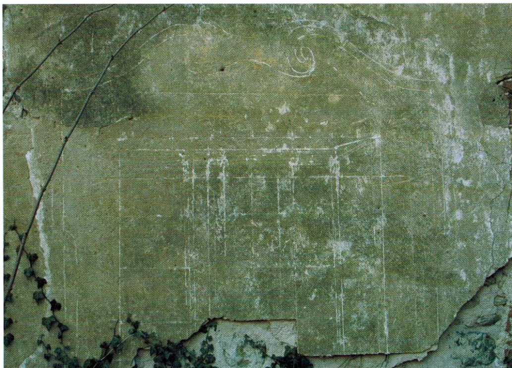
Immagine 5. (febbraio 2006). Nicchia recante tracce di decorazione con cornice a voluta, all'interno della quale si intravede il disegno del telaio di un infisso a simulazione di una finestra reale.
