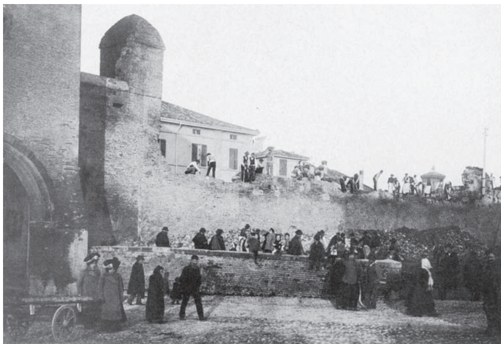
Flaminio volle vedere i lavori in corso per l'abbattimento delle mura antiche di Bologna e "restò perplesso di fronte alle rovine e a quella moltitudine di gente al lavoro per distruggere ciò che secoli prima era costato altrettanto lavoro per essere costruito". Questa è una delle molte fotografie scattate nel 1902 da Giuseppe Cavazza su incarico del Comune di Bologna (tratta da: a cura di MARCO POLI, In nome del progresso 1902-1904 – l'abbattimento delle mura di Bologna, Bologna, 2002)
