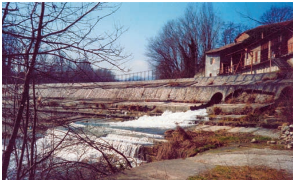
La chiusa di Vizzano sul fiume Reno, dove si trovano le opere di presa del canale che forniva la forza motrice ai mulini nel territorio di Pontecchio: un mulino da carta, uno da grano e uno "da polvere da schioppo" (foto P. Michelini)
