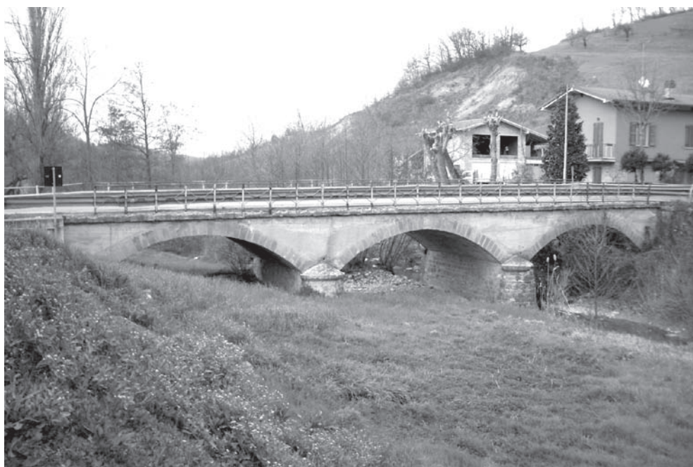
Il ponte sul torrente Lavino in località Pilastrino costruito nel 1926 (foto P.Michelini)
