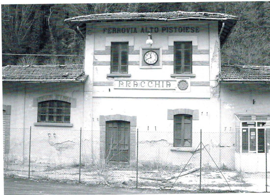
La stazione capolinea della Ferrovie Alto Pistoiese, come si presenta oggi, di fronte alla stazione della Ferrovie Porrettana di Pracchia (foto P. Michelini)
