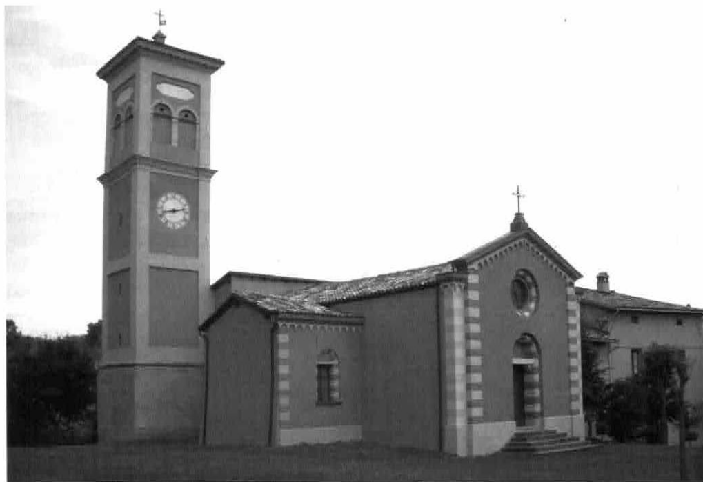
Chiesa di S.Chierlo: località situata sulle colline che guardano la sponda destra del torrente Lavino dove abitò la famiglia di nonno Flaminio (foto P. Michelini)
