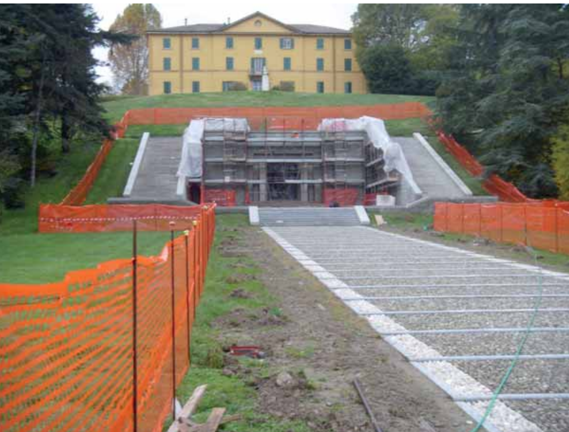
Fig. 3 I lavori di restauro del Mausoleo Marconi. Novembre 2009 (foto Ufficio Tecnico Comune di Sasso Marconi)
