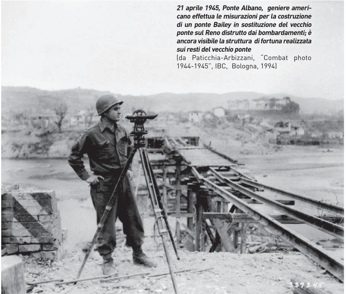
**21 aprile 1945, Ponte Albano, geniere americano effettua le misurazioni per la costruzione di un ponte Bailey in sostituzione del vecchio ponte sul Reno distrutto dai bombardamenti; è ancora visibile la struttura di fortuna realizzata sui resti del vecchio ponte**
